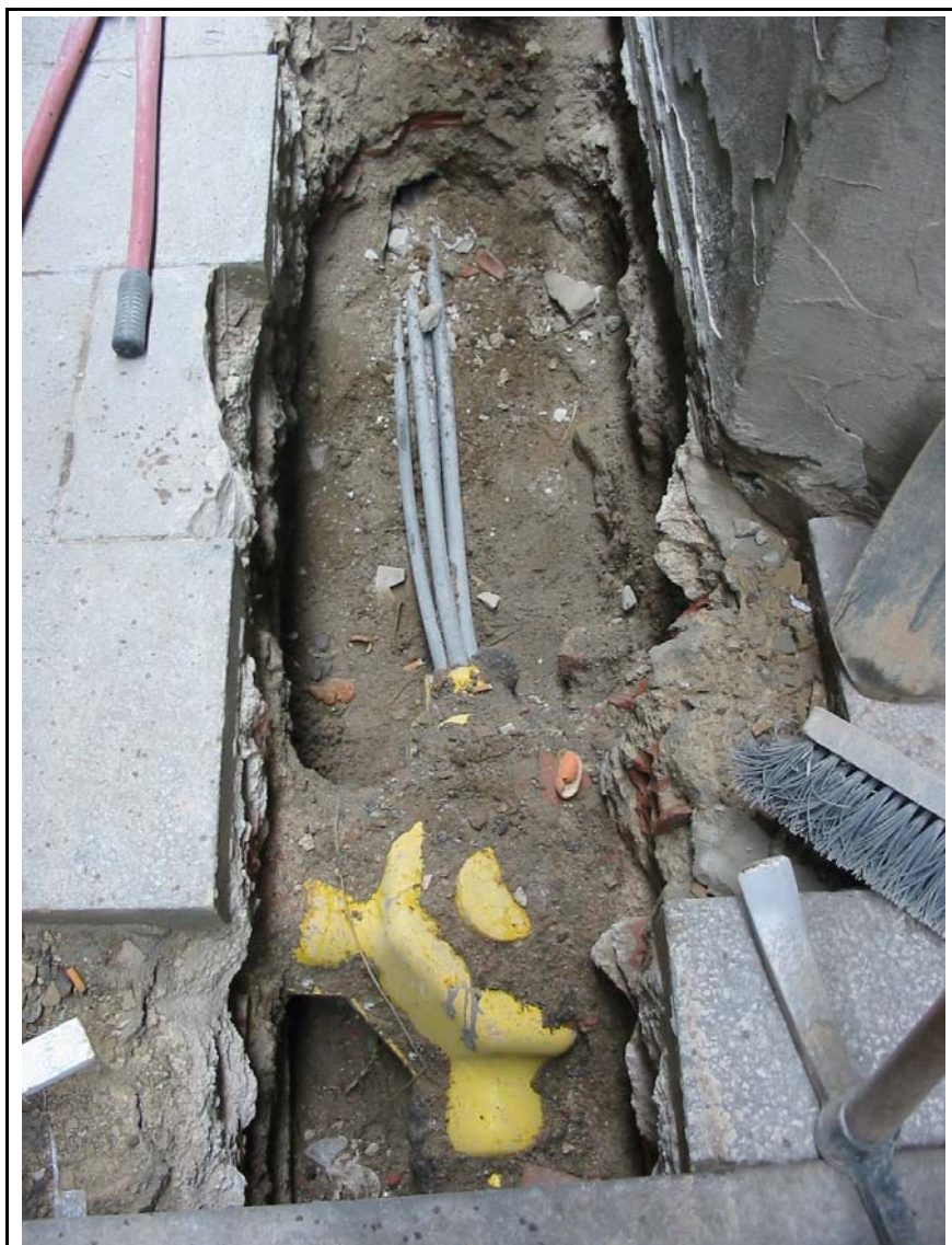
Fotografia 5. Vista dels serveis.
