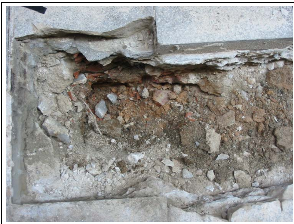
Fotografia 6. Detall del rebliment de la rasa.
