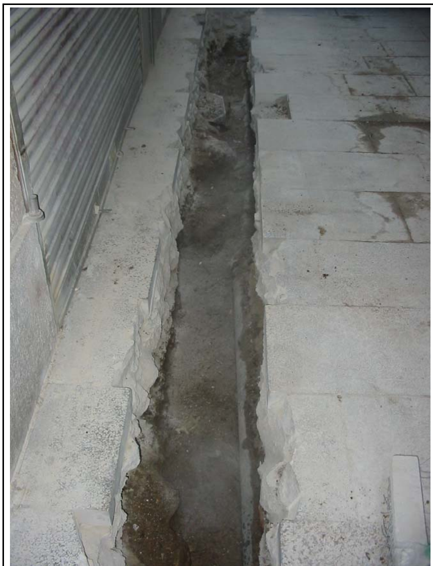
Fotografia 4. Vista de la rasa una vegada extret el paviment i la seva preparació.
